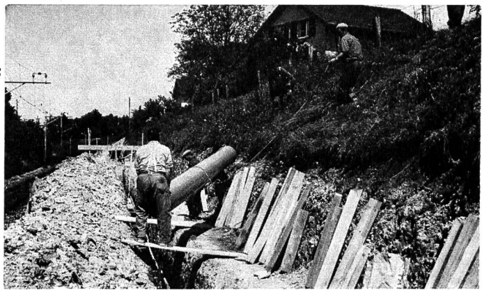
KALIDUR-Kanalisationsrohre, verlegt im Bahneinschnitt
