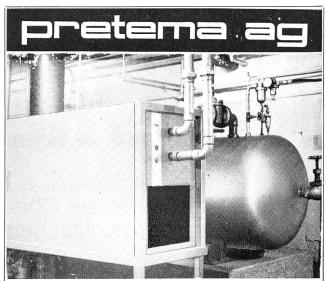
Druckluft-Trockner in Aerosol-Abfüllstation
