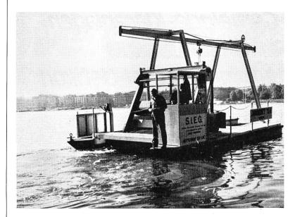
bestehend aus einem Feinrechen mit Rechenreinigungsmaschine, zusammen zwischen zwei motorisierten Schwimmkästen eingebaut. Dieses Reinigungsschiff dient dazu, jegliche Schwimmstoffe von der Wasseroberfläche von Gewässern, insbesondere Seen, Staugebieten usw. zu entfernen.
