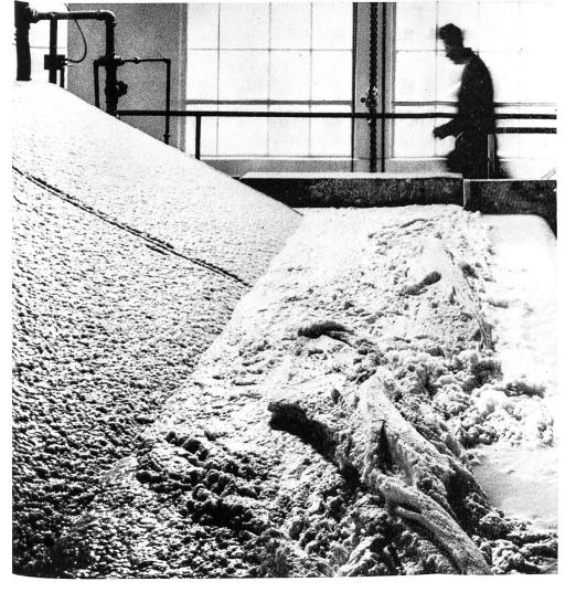
Wacofilter. Links Sieb mit Hilfsfilterschicht
