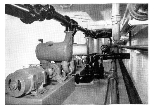
selbstansaugend ventillos System Lauchenauer
