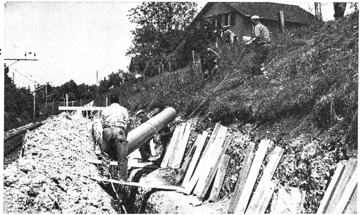
KALIDUR-Kanalisationsrohre, verlegt im Bahneinschnitt
