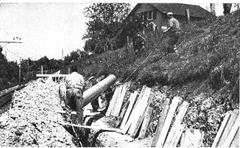
KALIDUR-Kanalisationsrohre, verlegt im Bahneinschnitt
