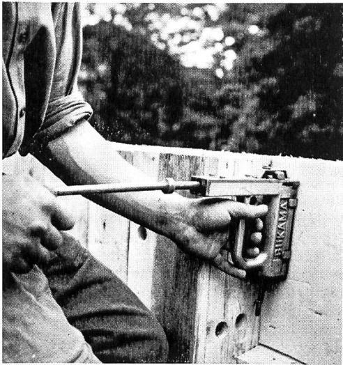
Abb. 1. Befestigen einer PVC-Schaumstoffplatte mit Hilfe eines Rohrhefters und Heftklammern an der Schalung aussen
