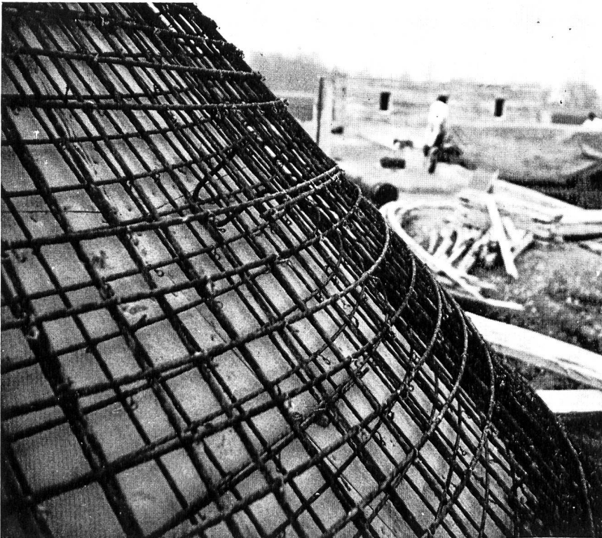
Abb. 2. Stahlarmierung auf Airex® verlegt.
