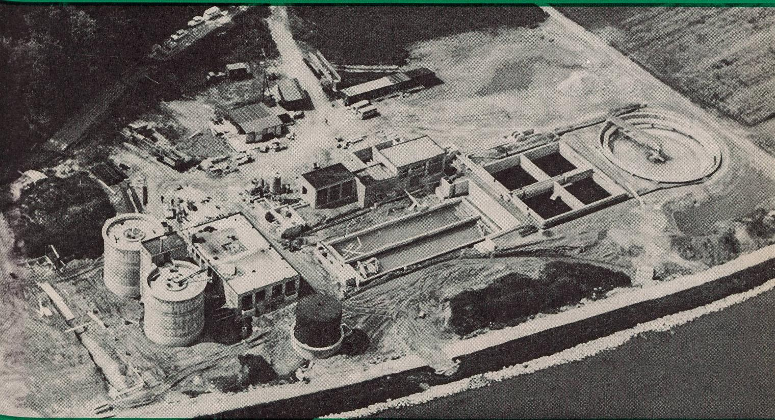
ARA Wangen an der Aare (17 000 EGW), 4 BSK-Turbinen  $\varnothing$  1500 mm mit einer O<sub>2</sub>-Kapazität von 130 kg O<sub>2</sub>/h
