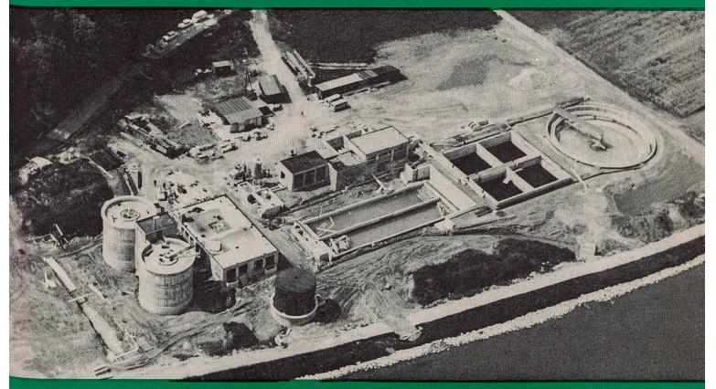
ARA Wangen an der Aare (17 000 EGW), 4 BSK-Turbinen Ø 1500 mm mit einer O2-Kapazität von 130 kg O2/h
