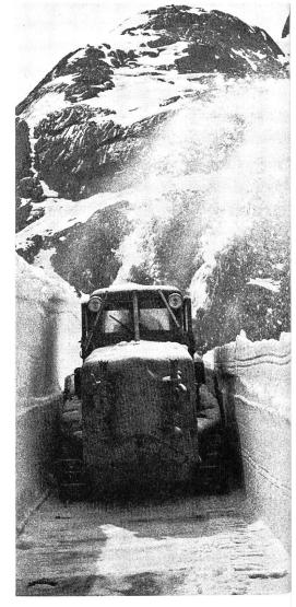
Abb. 3. Schneeräumung auf der Grimsel. Die Schneefräse befindet sich noch 6 m über dem Strassenniveau!
