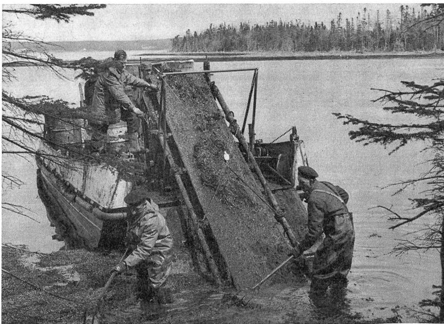
Fig. 3. On s'est servi de «slick-lickers», ou bandes transporteuses couvertes d'une toile de coton bouclé pour absorber le mazout répandu à la surface des eaux
