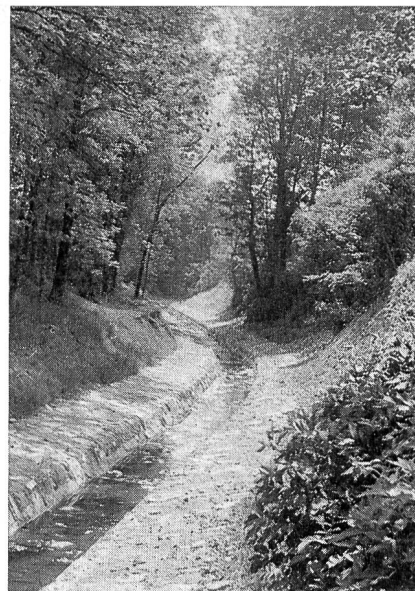
Korrektur des Stadtbaches von Altstätten (Melioration der Rheinebene). Natursteinpflasterung mit Niederwasserrinne, unter Schonung des bestehenden prachtvollen Baumbestandes.
