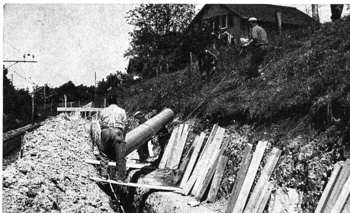
KALIDUR-Kanalisationsrohre, verlegt im Bahneinschnitt
