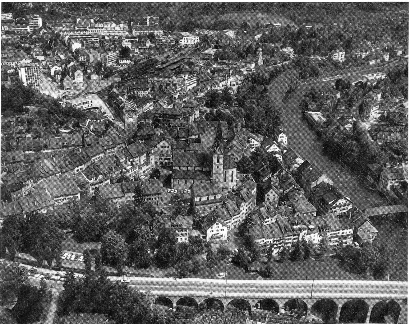
Abb. 1. Baden; Flugaufnahme des Zentrums mit Altstadt im Vordergrund, Limmatlauf rechts, Industriebereich der AG Brown, Boveri & Cie., oben links
