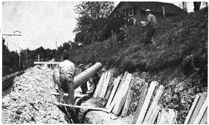
KALIDUR-Kanalisationsrohre, verlegt im Bahneinschnitt
