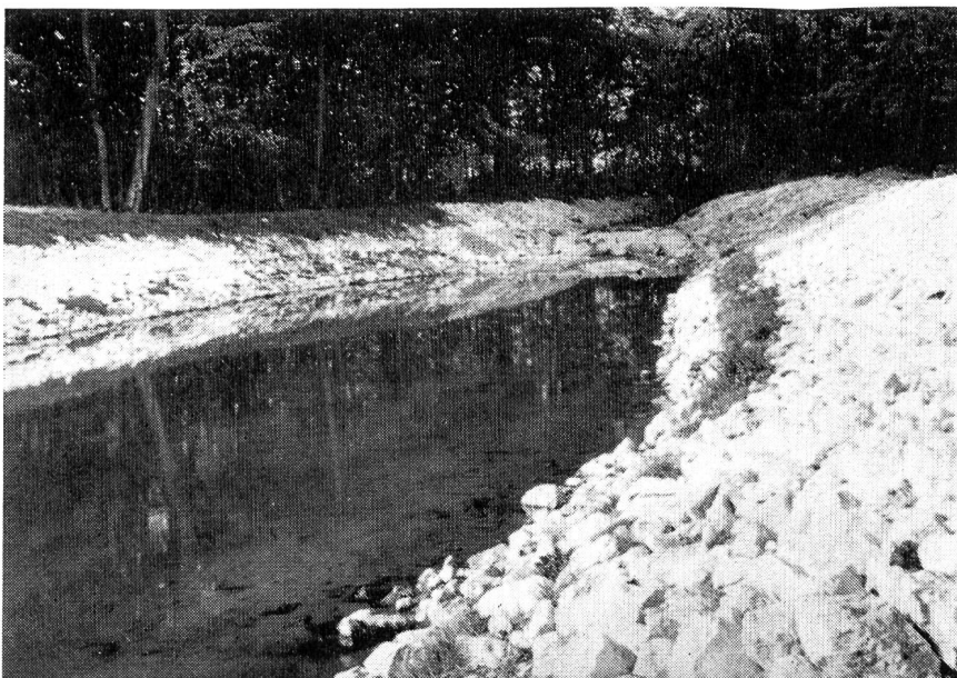
Abb. 5. Die Wahl des Blockwurfes oder der Steinschüttung zum Schutz der Ufer bei der II. Juragewässerkorrektion und bei den Kraftwerken Flumenthal und Bannwil darf als das bedeutendste Element für die Wiederherstellung einer gesunden Flusslandschaft bezeichnet werden. Blockwurf ist landschaftsfreundlich Innerhalb kurzer Zeit können auf der rauhen Steinoberfläche die wichtigen Kleinlebewesen wieder Fuss fassen. Diese leben von den Schmutzstoffen im Wasser und produzieren den für die natürliche Gewässerreinigung bedeutsamen Sauerstoff. Im Bild der Kiesfang an der Siggernmündung
