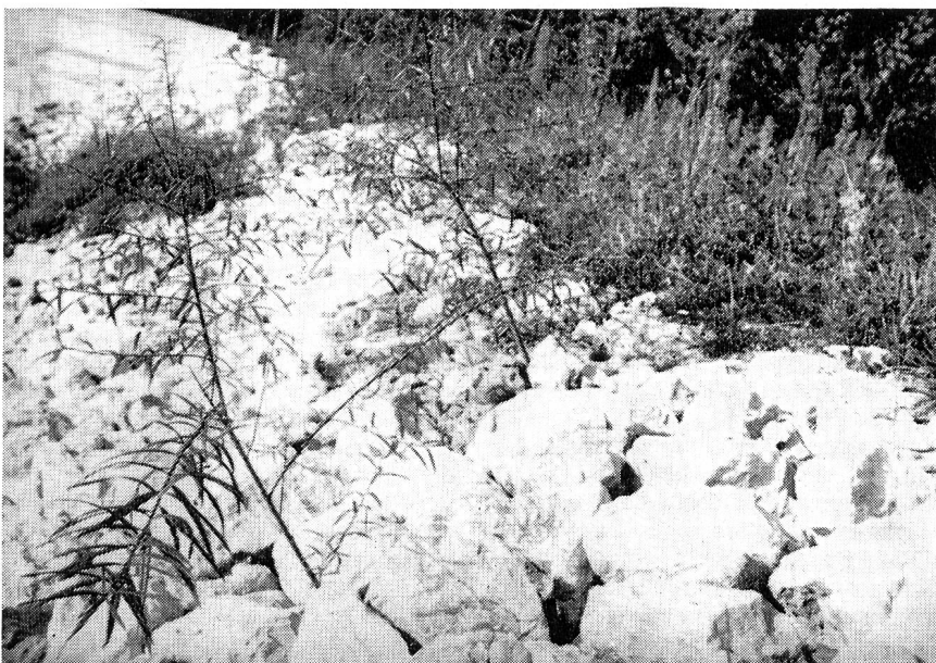
Abb. 7. In den Zwischenräumen der Steinschüttung bleiben in kurzer Zeit angeschwemmter Sand und Schlack hängen. Bald fliegt auch die natürliche Vegetation von selber an. Gräser, Weiden u. a. m. besiedeln den Blockwurf, der ein natürliches Aussehen bekommt und sich gut in die Landschaft einpasst. Beim Kraftwerkbau Flumenthal wird die starre geometrische Oberkanten-Blocklinie durch Aufwerfen von Humus mit dem Bagger gebrochen. Auf dem Bild im Vordergrund sind zwei Weiden erkennbar, die im Frühjahr 1969 als Stecklinge eingebracht wurden
