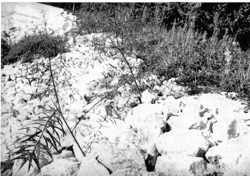
Abb. 7. In den Zwischenräumen der Steinschüttung bleiben in kurzer Zeit angeschwemmter Sand und Schlack hängen. Bald fliegt auch die natürliche Vegetation von selber an. Gräser, Weiden u. a. m. besiedeln den Blockwurf, der ein natürliches Aussehen bekommt und sich gut in die Landschaft einpasst. Beim Kraftwerksbau Flumenthal wird die starre geometrische Oberkanten-Blocklinie durch Aufwerfen von Humus mit dem Bagger gebrochen. Auf dem Bild im Vordergrund sind zwei Weiden erkennbar, die im Frühjahr 1969 als Stecklinge eingebracht wurden
