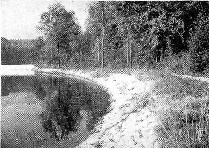
Abb. 4. Kiesfang Emmemündung rechtes Ufer. Blick flussabwärts. Die Betonmauer im Hintergrund soll noch mit einer Schilfpflanzung abgedeckt werden
