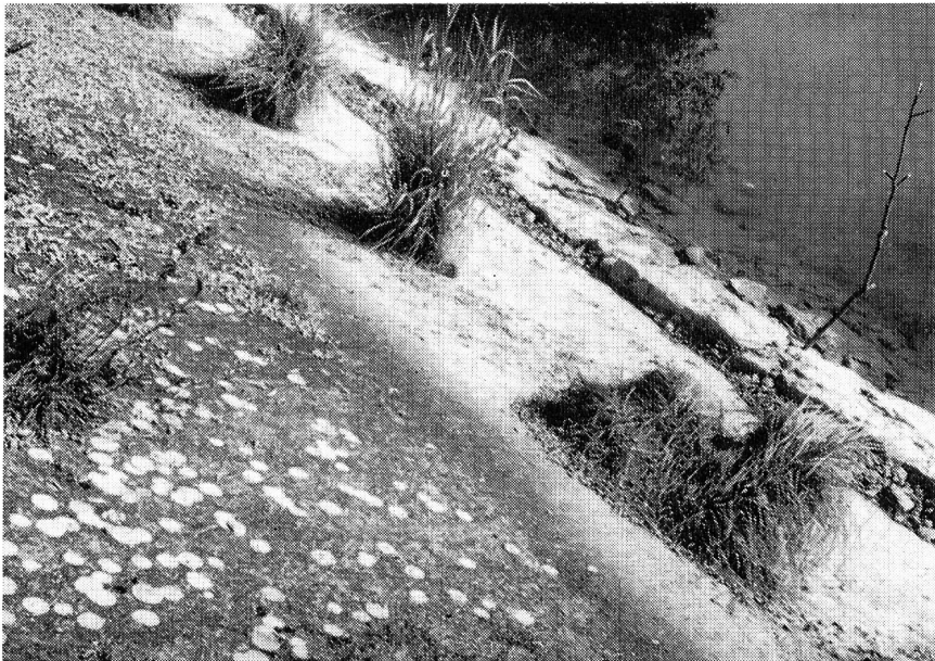
Abb. 6. Im Gegensatz zum Blockwurf sind Betonplatten landschafts- und lebensfeindlich. Die für die natürliche Selbstreinigungskraft des Gewässers wichtigste Uferzone mit der sog. Benthos-Besiedlung wird abgetötet. Nach deutschen Untersuchungen können auf der Steinschüttung rund 100mal mehr Kleinlebewesen (Bakterien, Algen, Pilze, Schnecken usw.) leben, als auf der Betonwand
