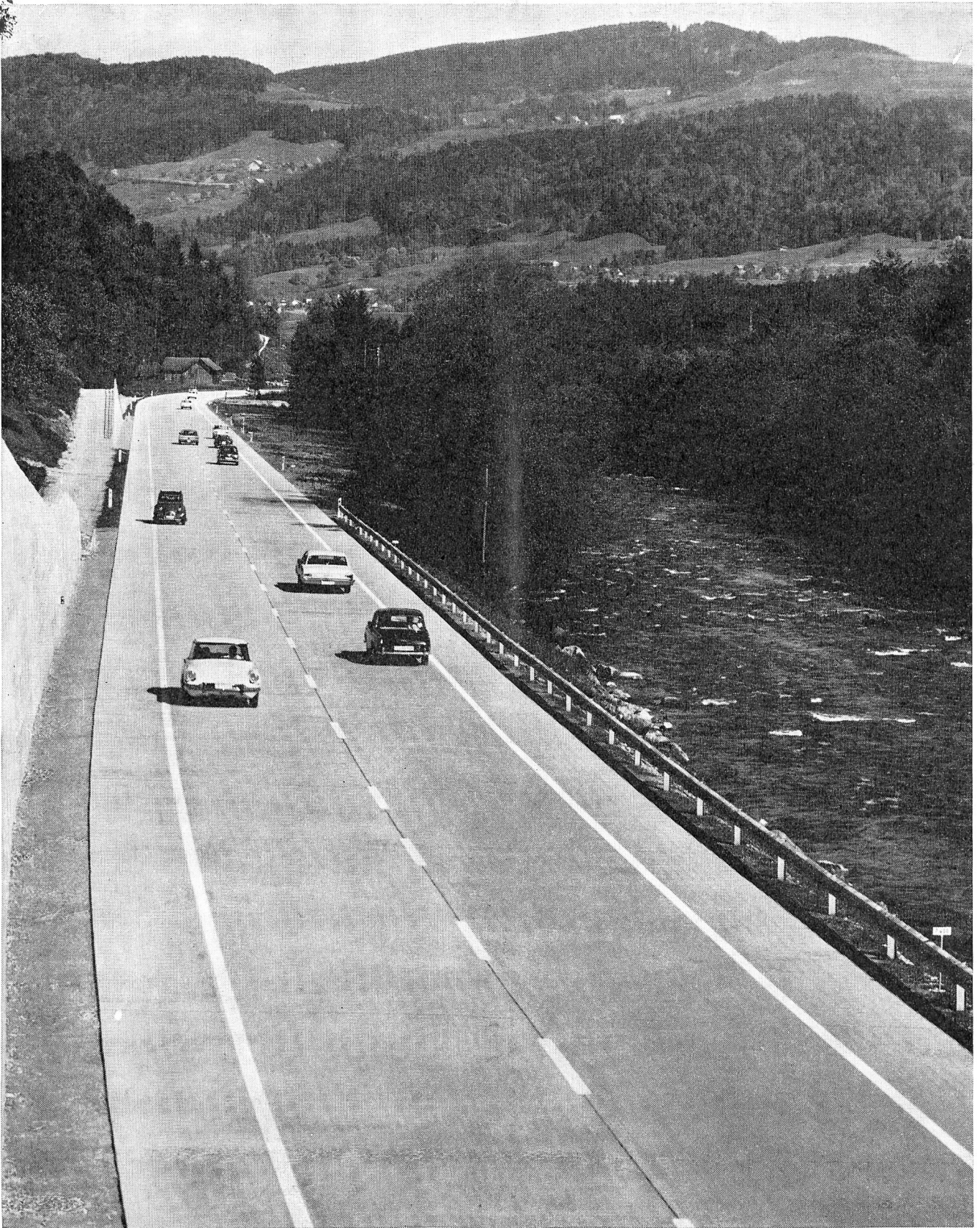
Luzern-Bern T 10, Umfahrung Malters, Betonbelag
