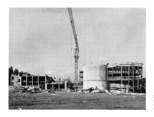
Fig. 3. Station d'épuration de Vidy. Vue sur les épaississeurs de boues et la station de déshydratation et d'incinération.
