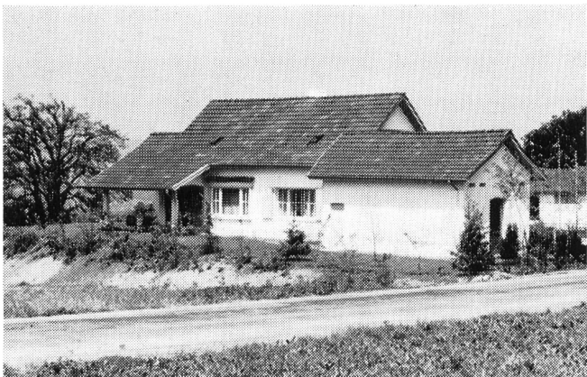
Abb. 5. An Einfamilienhaus angebaute Transformatorenstation in Uitikon.
