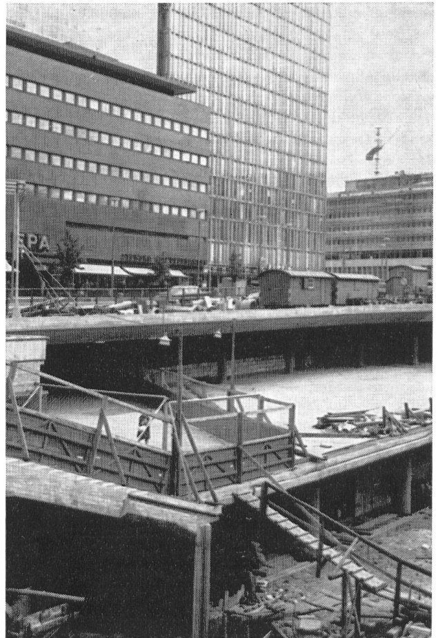
Abb. 4. City-Sanierung in Stockholm: Bau verschiedener Verkehrsebenen beim Sergels torg.
