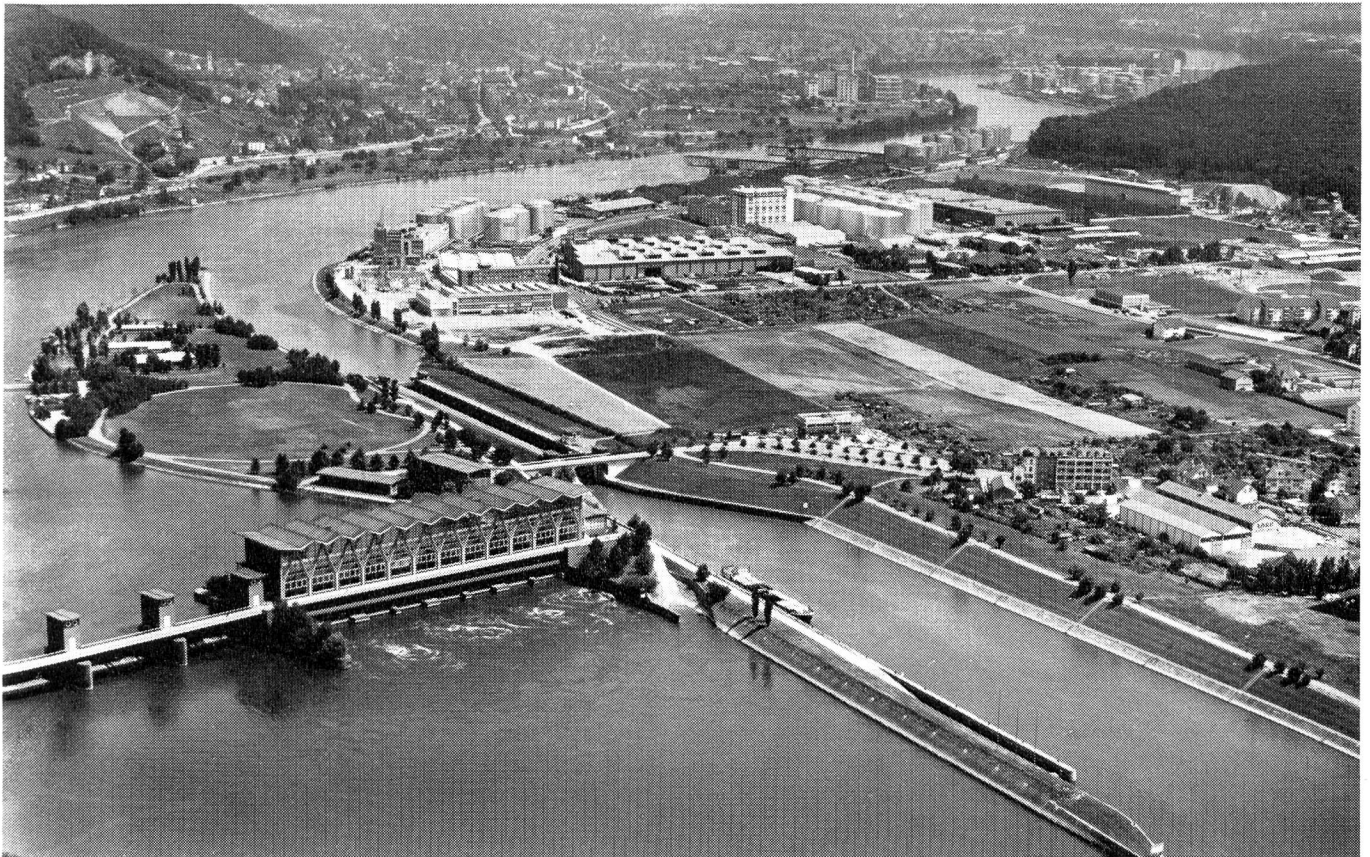
Abb. 2. Kraftwerk Birsfelden mit Schleuse, dahinter die Rheinhäfen Birsfelden und Au (Baselland).
