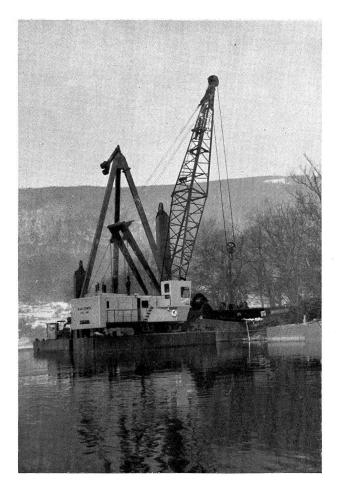
Abb. 20. Der «Manitowoc» bei der Fertig-Selbstmontage im Kanaleinlauf am Bielersee. Links und rechts die beiden lotrechten Seitenspuds von je 20 m Länge, Querschnitt 1,1 × 1,1 m.
