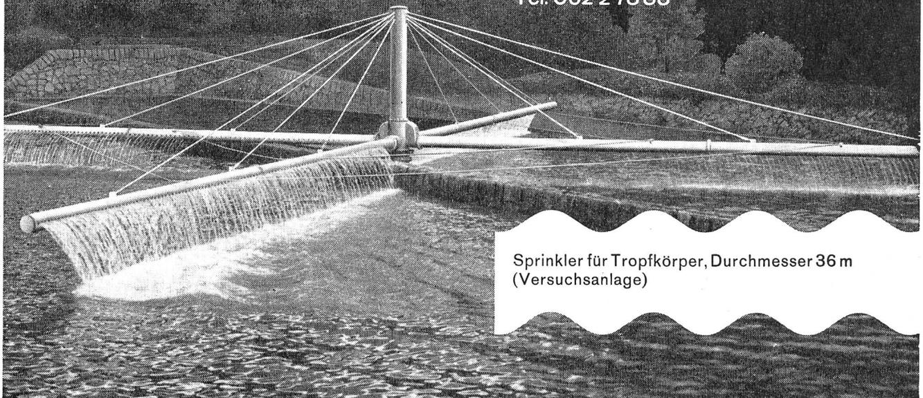
Sprinkler für Tropfkörper, Durchmesser 36 m
