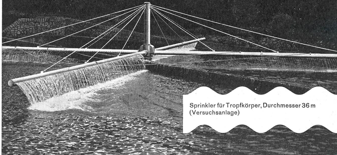
Sprinkler für Tropfkörper, Durchmesser 36 m
