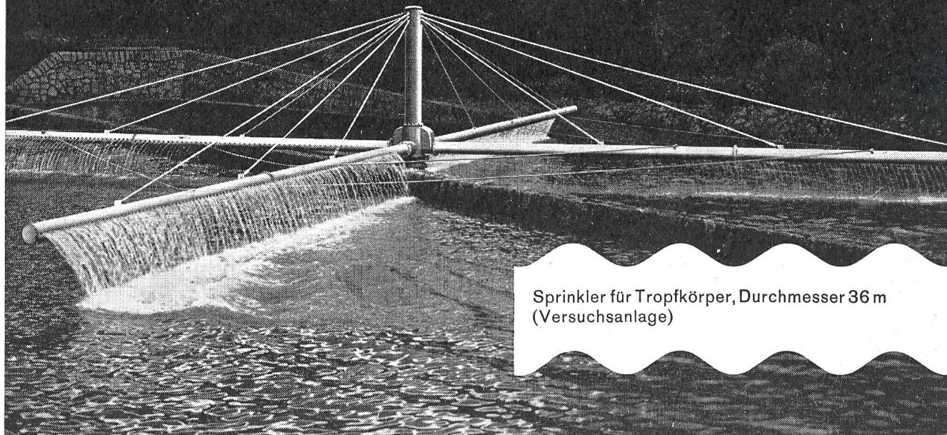
Sprinkler für Tropfkörper, Durchmesser 36 m
