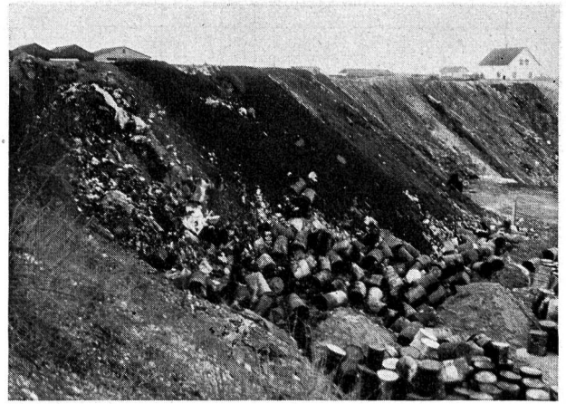
Abb. 2. Auffüllung der Kiesgrube mit Chemieabfällen, welche zum Teil in den auf dem Bild sichtbaren Eisenfässern antransportiert wurden.
