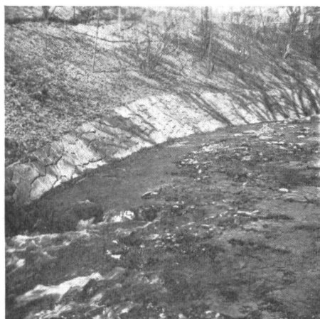
Unauffällige Bachverbauung, die auch Hochwasser überlebte!
