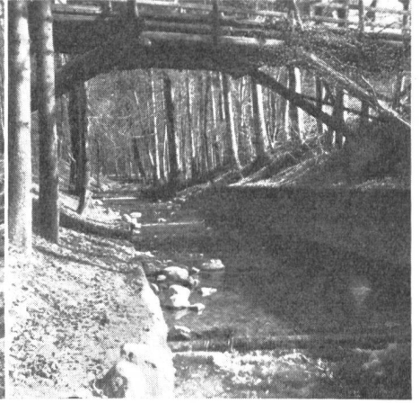
Durch Brückenbau, starke Beschattung und grosse Böschungsneigung, ferner fehlenden Humus, entstand diese Uferpartie — ohne Vegetationsdecke.
