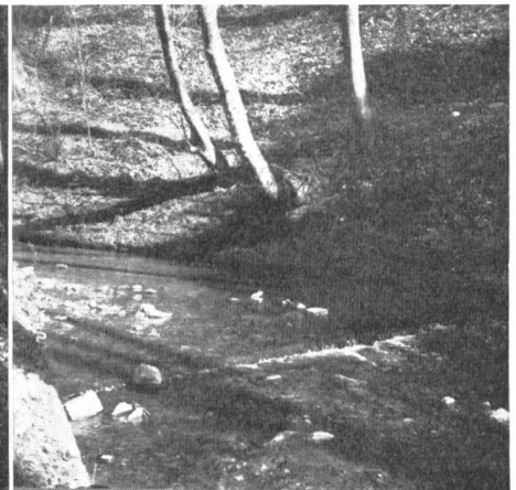
Gute, kaum sichtbare Uferverbauung aus Naturstein, die auch dem Hochwasser (trotz Kurve) standhielt!
