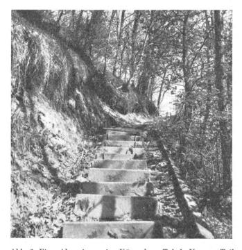
Abb. 2. Eine Abzweigung im Küsnachter Tobel. Unterer Teil der Treppe mit eisenverstrebten Zementstellriemen. Oberer Teil richtigerweise mit alten Eichenschwellenstufen.
