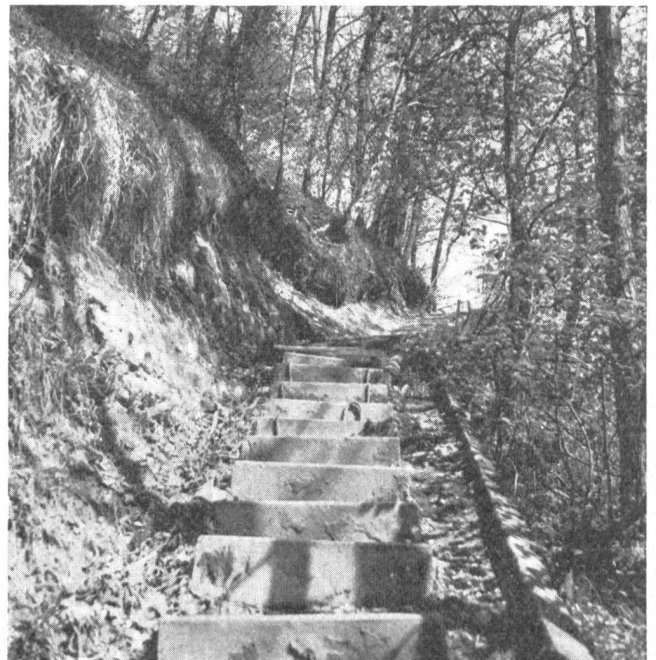
Abb. 2. Eine Abzweigung im Küssnachter Tobel. Unterer Teil der Treppe mit eisenverstärkten Zementstellriemen. Oberer Teil richtigerweise mit alten Eichenschwellenstufen.
