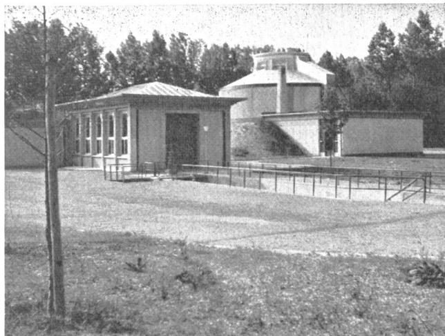
Fig. 2. Dessableur, station de pompage, digesteur des boues.
