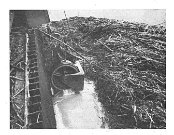
Abb. 4. Geschwemmselwalze (Hochwasser), Kraftwerk Birsfelden.
