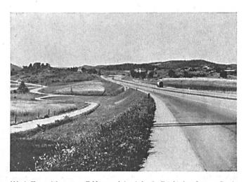
Abb. 8. Kurvenführung von Feldweg und Autobahn im Fränkischen Jura. — Dessin de virage d'un chemin de campagne et d'une voie de grande communication dans le Jura franconien. — Curve of a field-road and freeway in the Franconian Jura.
