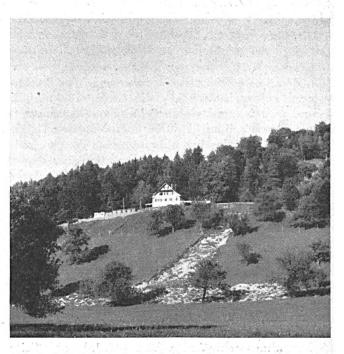
Abb. 9. Geländeformation und Abrutschung an der Strasse Buchenegg-Reppischtal.
