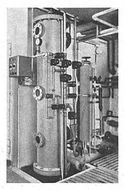
Abb. 11. Ionenaustauschanlage zur Reinigung von Chrombadflüssigkeiten.
