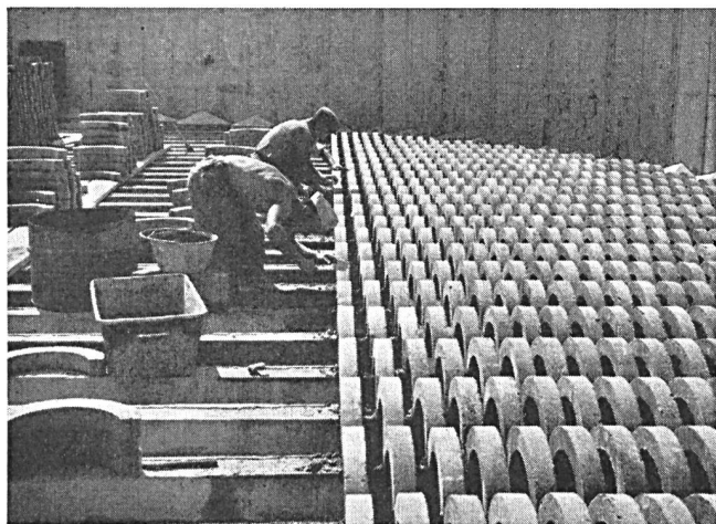
Abb. 6. Belüftungssteine am Boden der Tropfkörper. Die Konstruktion mit gewölbten Belüftungssteinen sorgt für eine sehr gute Belüftung der Tropfkörper.
