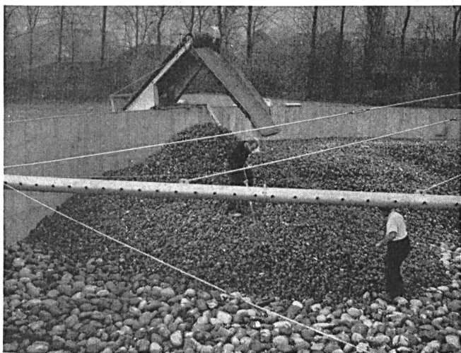
Abb. 7. Einbringen der Tropfkörperfüllung. Unten erkennt man eine Schicht von grossen Steinen, die den Uebergang zu den Ablaufrinnen bilden. Die eigentliche Füllung der Tropfkörper besteht aus Alpenkalkschotter.
