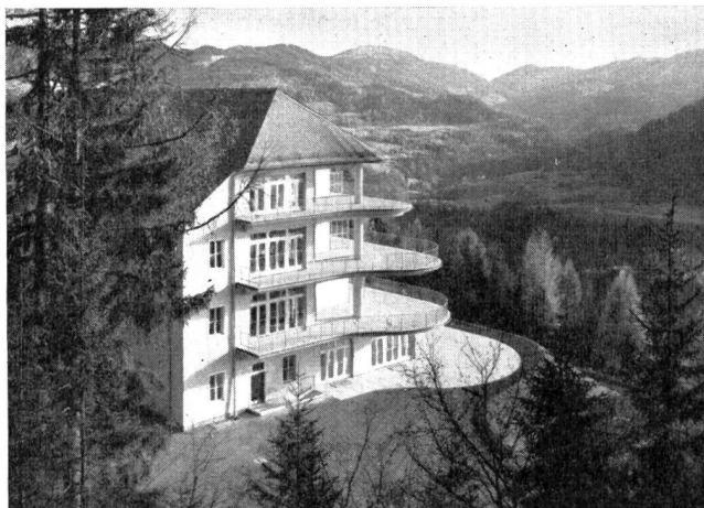
Abb. 15. «Sonnenheilstätte Stolzalpe, Kinderheim.» Bauherr: Land Steiermark. Entwurf: Steiermärkisches Landesbauamt, Landeshochbau, Ing. Franz Plentner. Photo: E. M. Fürböck, Graz; zur Verfügung gestellt vom Steiermärkischen Landesbauamt, Landeshochbau.
