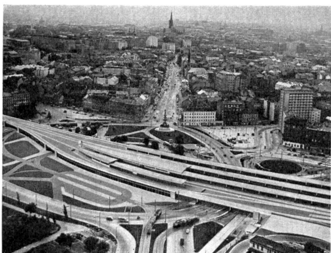
Abb. 23. «Wien, Praterstern.» Bauherr: Stadtgemeinde Wien. Photo: Pressestelle der Stadt Wien, Bilderdienst; zur Verfügung gestellt vom Magistrat Wien, Stadtbaudirektion.
