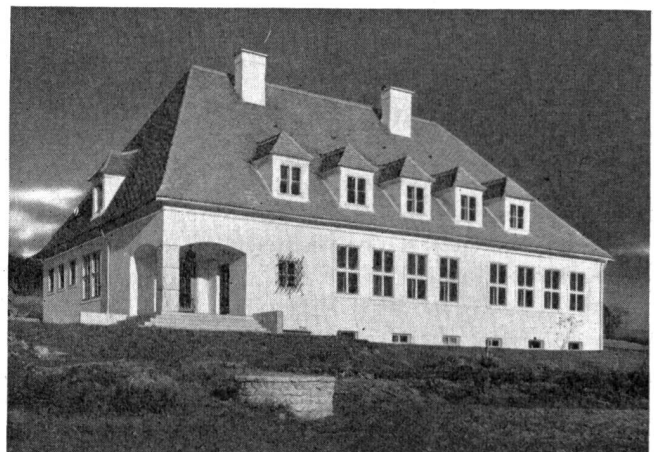
Abb. 19. «Vierklassige Volksschule in Pressguts.» Bauherr: Gemeinde Pressguts, Oststeiermark. Entwurf: Arch. Ing. Sepp Lieb, Weiz und Baubezirksamt Graz. Photo: E. M. Fürböck, Graz; zur Verfügung gestellt vom Steiermärkischen Landesbauamt, Landeshochbau.
