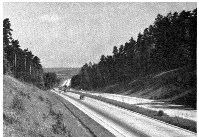
Abb. 3. Eine Linienführung, die nicht voll befriedigt. Steigung mit 7 % zu gross. Die Zwischengerade würde heute durch zwei Klothoidenäste ersetzt werden.
