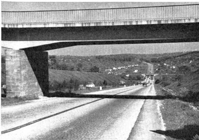
Abb. 2. Ueberquerung des Enztales bei Pforzheim. Die beiderseitigen Steigungen mit jeweils 7 % sind zu gross. Autobahn liegt zu hart in der Landschaft.
