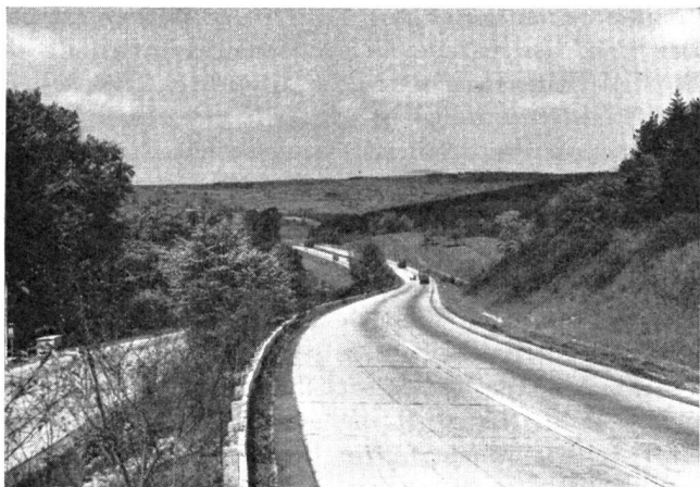
Abb. 4. In die Landschaft gut eingepasste Autobahn bei Pforzheim. Abstieg ins Pfinztal, jedoch noch ohne Anwendung von Klothoiden.
