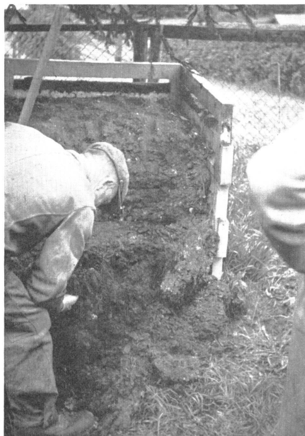
Abb. 5. Rippa-Silo für Kompostierung nicht zerkleinerten Rechengutes aus der Kläranlage St. Gallen. Oeffnung, vollständige Verrottung des sehr komplexen Rechengutes.
