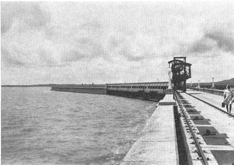
Abb. 9. Krishnaraj Sagar , bei Mysore, Süd-Deccan. Eine der grössten Stauanlagen Südindiens. Der bis 40 m hohe Querdamm staut den Cauvery-Fluss zu einem flachen See von 130 km 2 , welcher 480 km 2 Felder zu bewässern ermöglicht.
