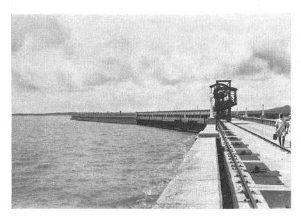
Abb. 9. Krishnaraj Sagar, bei Mysore, Süd-Deccan. Eine der grössten Stauanlagen Südindiens. Der bis 40 m hohe Querdamm staut den Cauvery-Fluss zu einem flachen See von 130 km², welcher 480 km² Felder zu bewässern ermöglicht.
