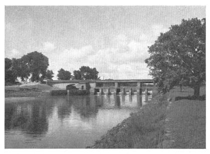
Abb. 8. Bhatinda-Kanal, ein Hauptverteiler des Sirhind-Systems, welches Wasser des aus dem Himalaya kommenden Sutlej in die Felder leitet. Die Anlagen stammen aus den achtziger Jahren des vergangenen Jahrhunderts.
