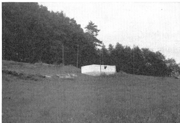
Abb. 3. Am Waldrand die Bauruine des ersten Projektes, darum herum die Profilstangen für das zweite, ebenfalls abgelehnte Projekt.
