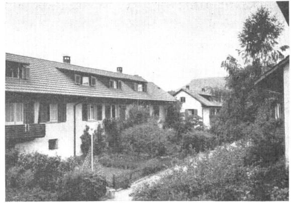
Abb. 3. Reiheneinfamilienhäuser der Wohnbaugenossenschaft Aarau 1942.
