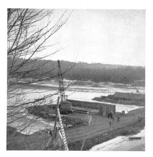
Abb. 6 a—b. Erste Bauetappe der neuen, tiefgelagerten Eisenbetonbrücke von Edmonton mit sieben Pfeilern.
