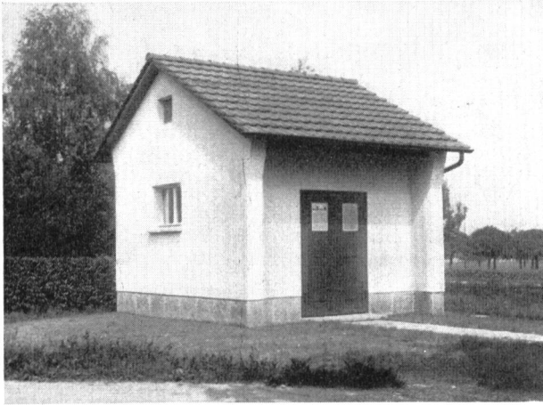
Abb. 3. Rheinfelden (Aargauisches Elektrizitätswerk).
