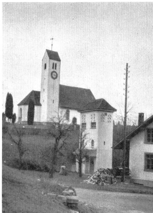
Abb. 1. Der Blick auf die sehr schön gelegene Kirche wird durch die Transformatorenstation beeinträchtigt.
