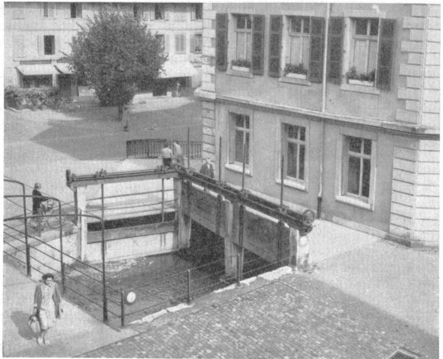
Abb. 2. Die Schleuse mit Pegel beim Gemeinde- haus; bei Hochwasser muss der linke Teil geöffnet werden; das Wasser fließt von hier in die Bahnhofstrasse.
