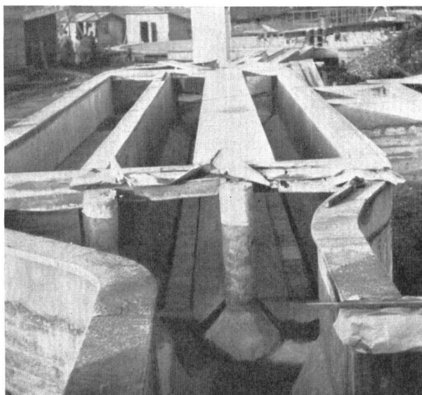
Abb. 6. Horizontal durchflossener Sandfang mit Bodenschlitz der Kläranlage Langenthal (BE) im Bauzustand.
