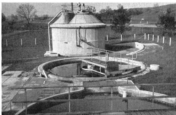
Abb. 9. Mechanisch-biologische Abwasserreinigungsanlage Flughafen Kloten für 1500 Einwohnerggleichwerte. Vordergrund: rundes Nachklärbecken. Mitte: kreisrundes, flaches Vorklärbecken. Hintergrund: Faulraum.
