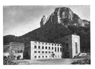
Abb. 6. Material, Bauweise und Gestaltung des Betriebsgebäudes der Kraftwerke Oberhasli passt sich der Gebirgslandschaft an.
