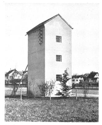
Abb. 7. Ein vom EKZ entwickelter Zweckbau einer Transformatorenstation.
