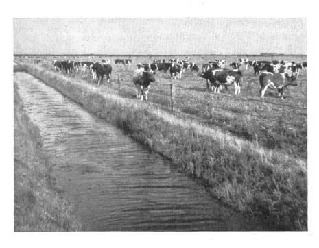
Abb. 3. Dank der Infiltrationsgräben wird der Wasserstand im sandigen Gebiet des Nordostpolders vollständig reguliert.
