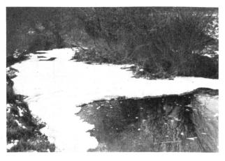
Abb. 6. Schaumdecke in einem kleinen, langsam fliessenden Gewässer als Folge der Einleitung von Abwässern einer etwa 1 km oberhalb dieser Stelle gelegenen Gerberei.
