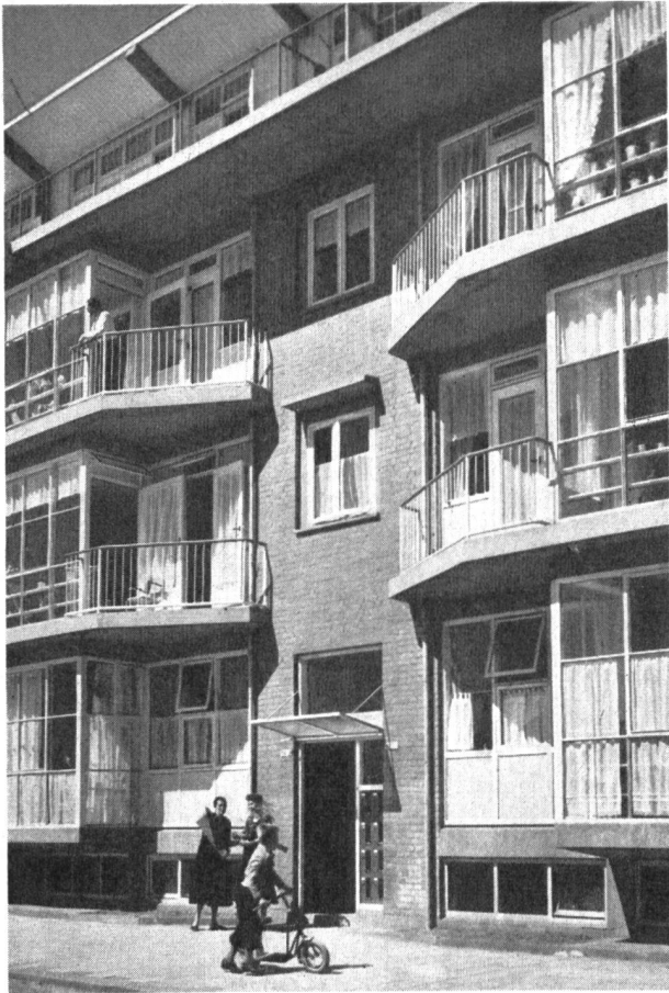
Abb. 2. Strassenseite eines Mietshauses in Rotterdam (Arch. Brinkman & Van den Broek) 1949.
