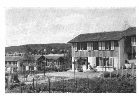
Fig. 2. Abitazione campestre alla periferia della città (Zollikerberg, Zurigo). Case collegate in fila riservate ciascuna ad una sola famiglia, il primo piano in costruzione di legno.
