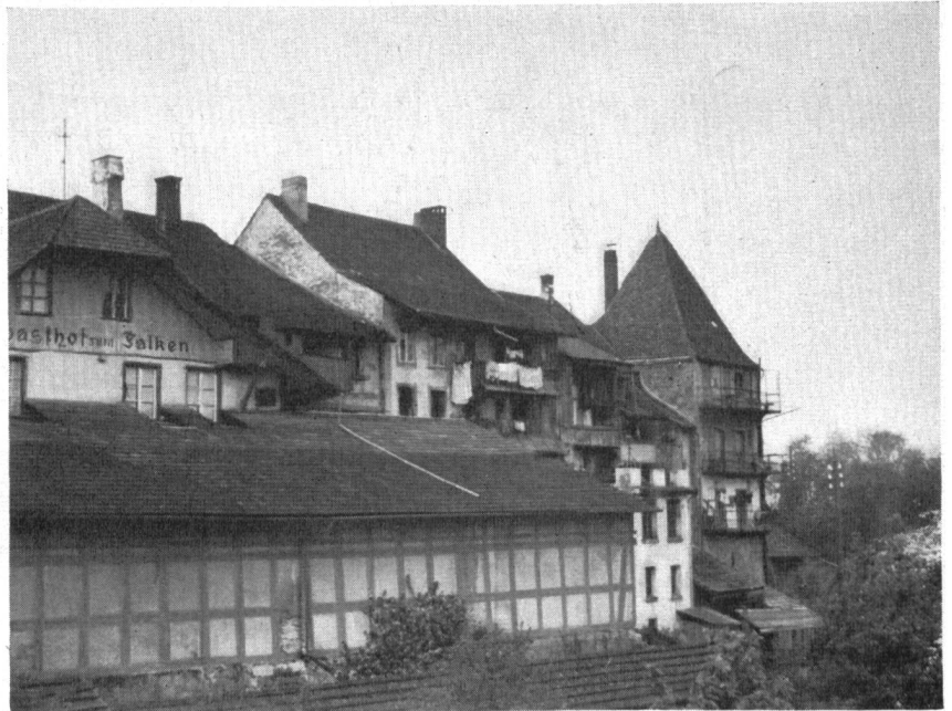
Abb. 13. Partie der Stadtmauer aus Nordosten gesehen. Die Anbauten aus späterer Zeit beeinträchtigten die ursprünglichen Baukörper empfindlich. Diese baufälligen Anbauten sind zum Teil bereits durch einen Neubau ersetzt, weitere Sanierung ist vorbereitet.
