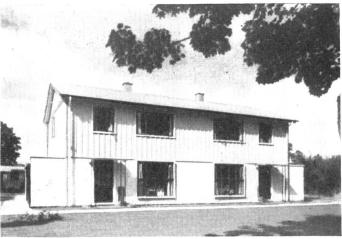
Abb. 1. Beispiel eines vorfabrizierten Haustyps in Stahlskelett mit Plattenverkleidung.
