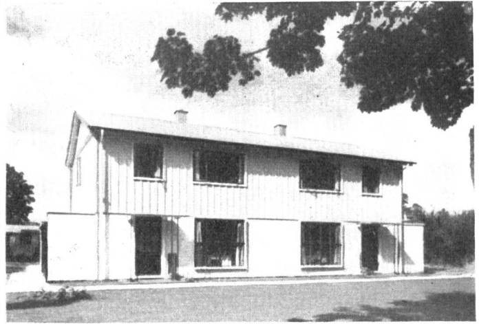
Abb. 1. Beispiel eines vofabrizierten Haustyps in Stahlskelett mit Plattenverkleidung.
